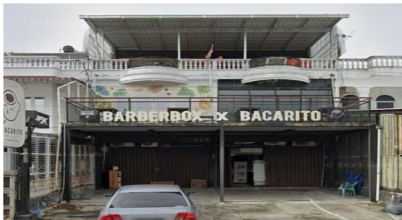
Gambar 1.1 Tampak Depan Bacarito Kopi Padang (Sumber: Dokumentasi Penulis)
