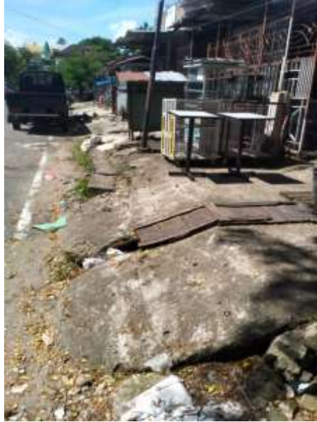
Gambar 1.1 Membangun di atas trotoar Sumber: Penulis (2023)
